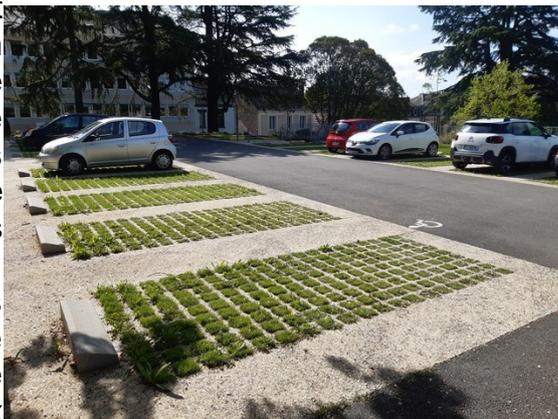
Les arbres en place ont été maintenus, des espaces verts ont été créés en périphérie des poches de stationnement, et le béton alvéolaire a permis de capter les eaux pluviales de toute la surface imperméable du parking.
